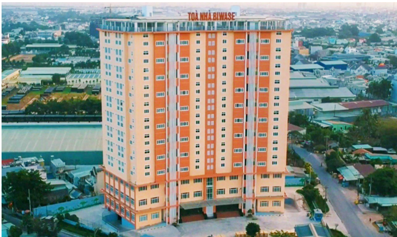
THI CÔNG CHUNG CƯ NHÀ Ở XÃ HỘI & CÔNG VIÊN CÂY XANH (TÒA NHÀ BIWASE) CONSTRUCTION OF SOCIAL HOUSING APARTMENT & GREEN PARK (BIWASE BUILDING)
