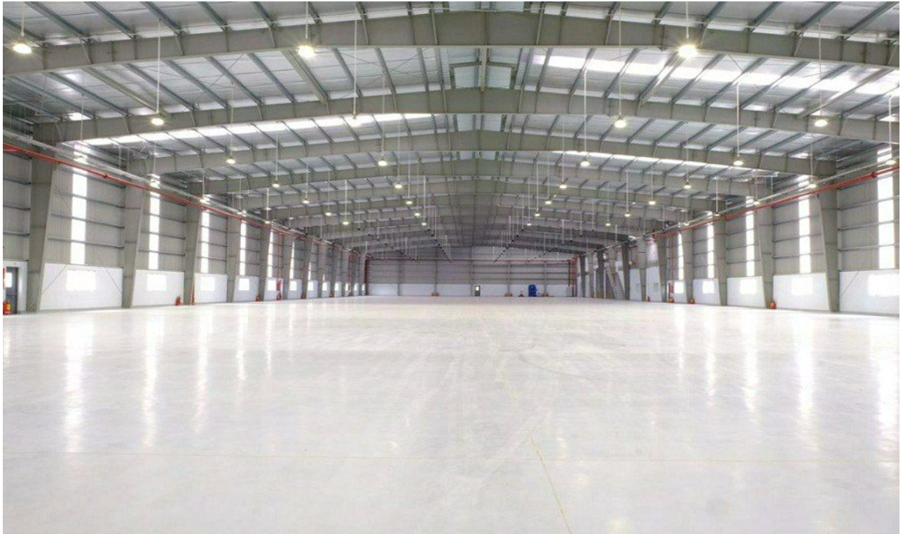
THI CÔNG XÂY DỰNG NHÀ XƯỞNG CÔNG NGHIỆP CONSTRUCTION OF INDUSTRIAL FACTORY
