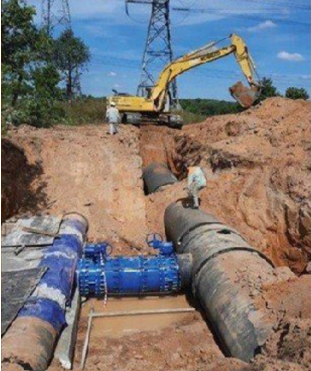
THI CÔNG ĐẦU NỐI ỐNG GANG VÀ PHỤ KIỆN D1500 - D1600mm DƯỚI NỀN ĐẤT YẾU CONNECTION AND INSTALLATION OF D1500 - D1600mm DUCTILE IRON PIPES AND FITTINGS UNDER WEAK SOIL
