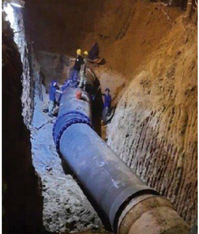
THI CÔNG ĐẦU NỐI ỐNG GANG VÀ PHỤ KIỆN D1500 - D1600mm DƯỚI NỀN ĐẤT YẾU CONNECTION AND INSTALLATION OF D1500 - D1600mm DUCTILE IRON PIPES AND FITTINGS UNDER WEAK SOIL
