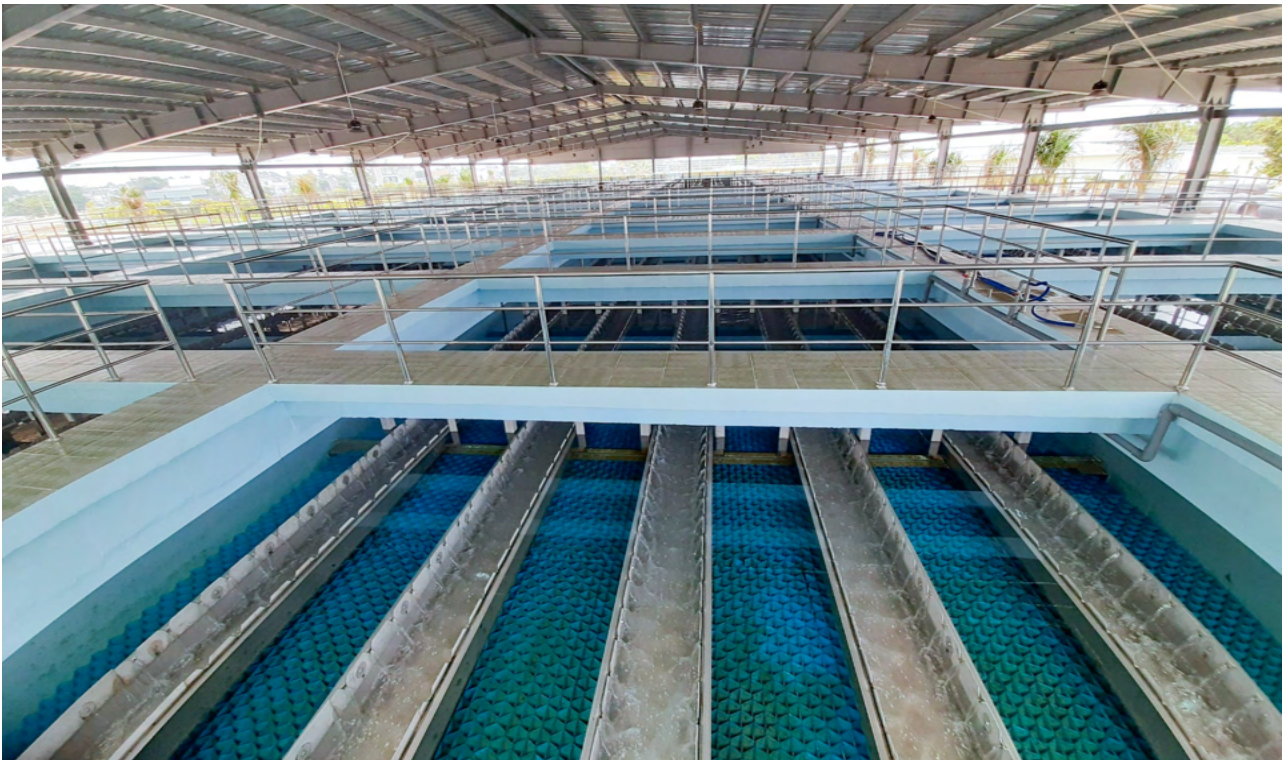
THI CÔNG LẮP ĐẶT ỐNG LẮNG LAMEN CONSTRUCTION AND INSTALLATION OF LAMEN SETTLING PIPES
