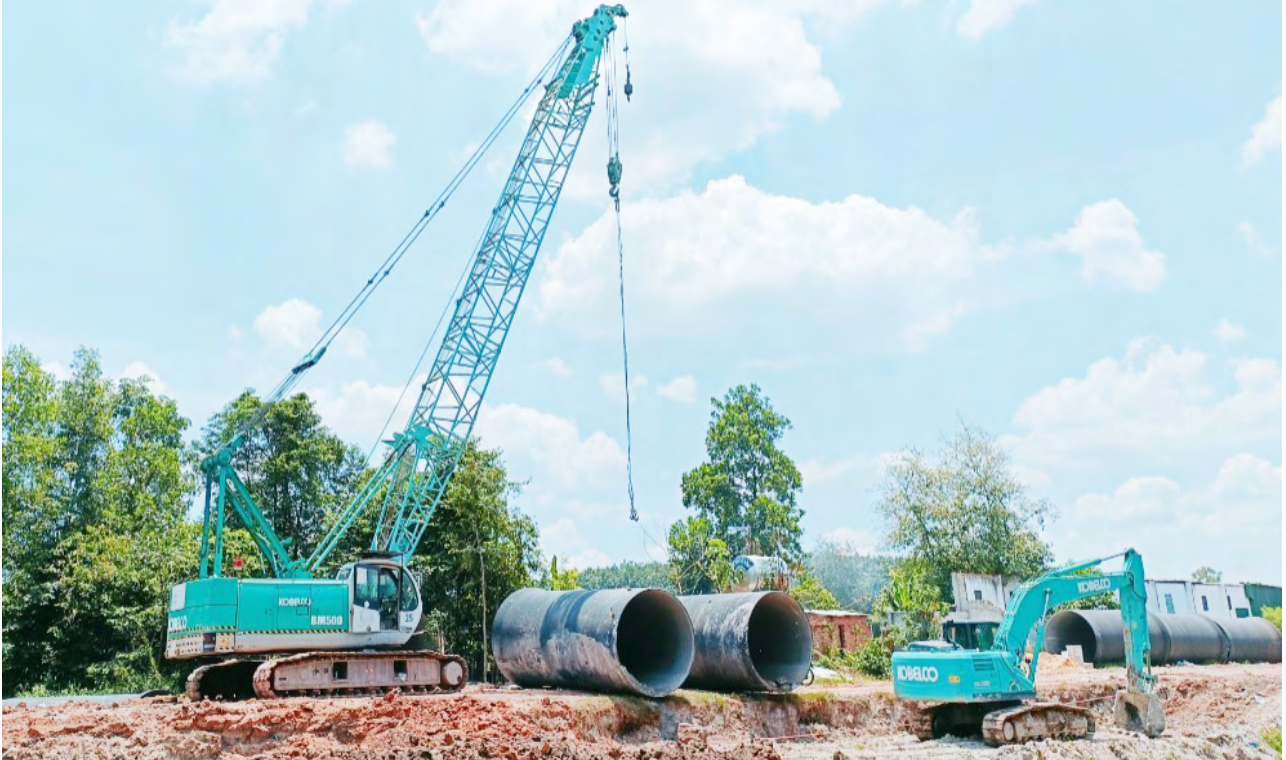
THI CÔNG LẮP ĐẶT TUYẾN ỐNG CẤP NƯỚC THÔ ĐƯỜNG KÍNH 2400mm CONSTRUCTING INSTALLATION OF RAW WATER SUPPLY PIPELINE WITH A DIAMETER OF 2400mm
