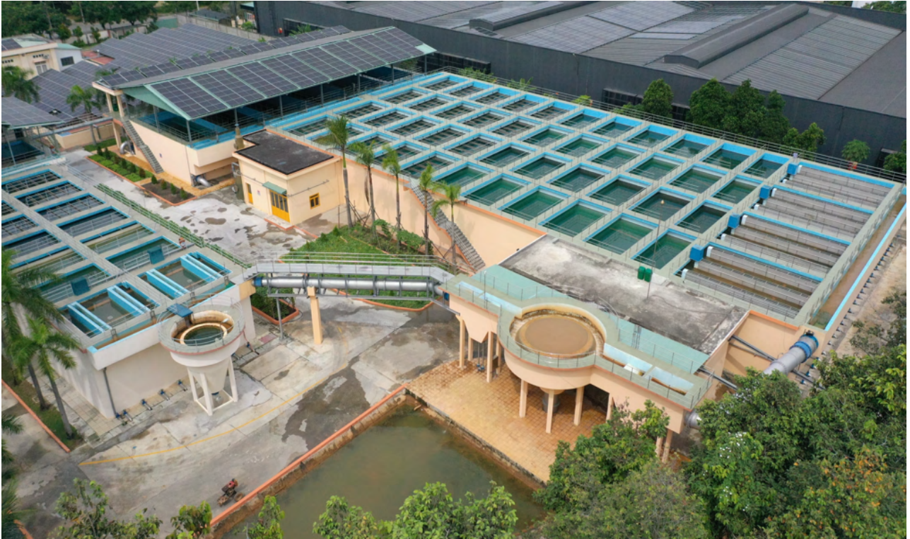
TOÀN CẢNH NHÀ MÁY NƯỚC NAM TÂN UYÊN CÔNG SUẤT 50.000 M 3 / NGÀY ĐÊM DO BIWELCO THI CÔNG OVERVIEW OF NAM TAN UYEN WATER TREATMENT PLANT WITH CAPACITY OF 50.000M 3 /DAY CONSTRUCTED BY BIWELCO
