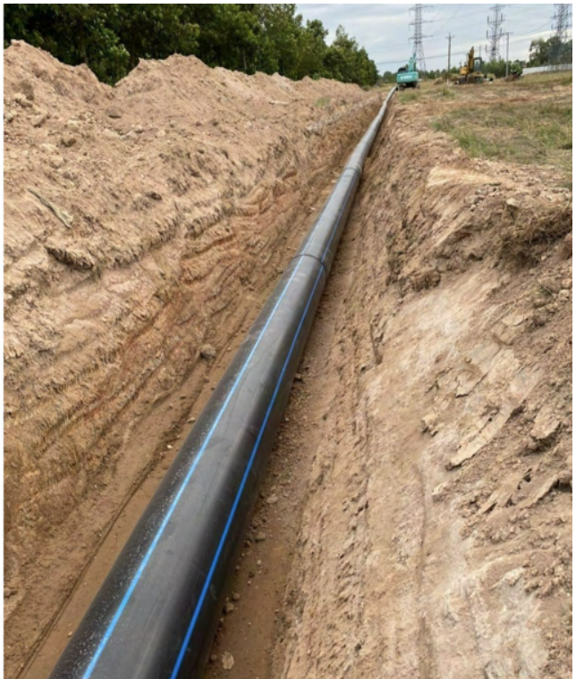
THI CÔNG TUYẾN ỐNG CHUYỂN TẢI NƯỚC THẢI VỀ TRẠM BƠM - TP MỚI BÌNH DƯƠNG CONSTRUCTION OF WASTEWATER TRANSFER PIPELINE TO PUMP STATION - BINH DUONG NEW CITY
