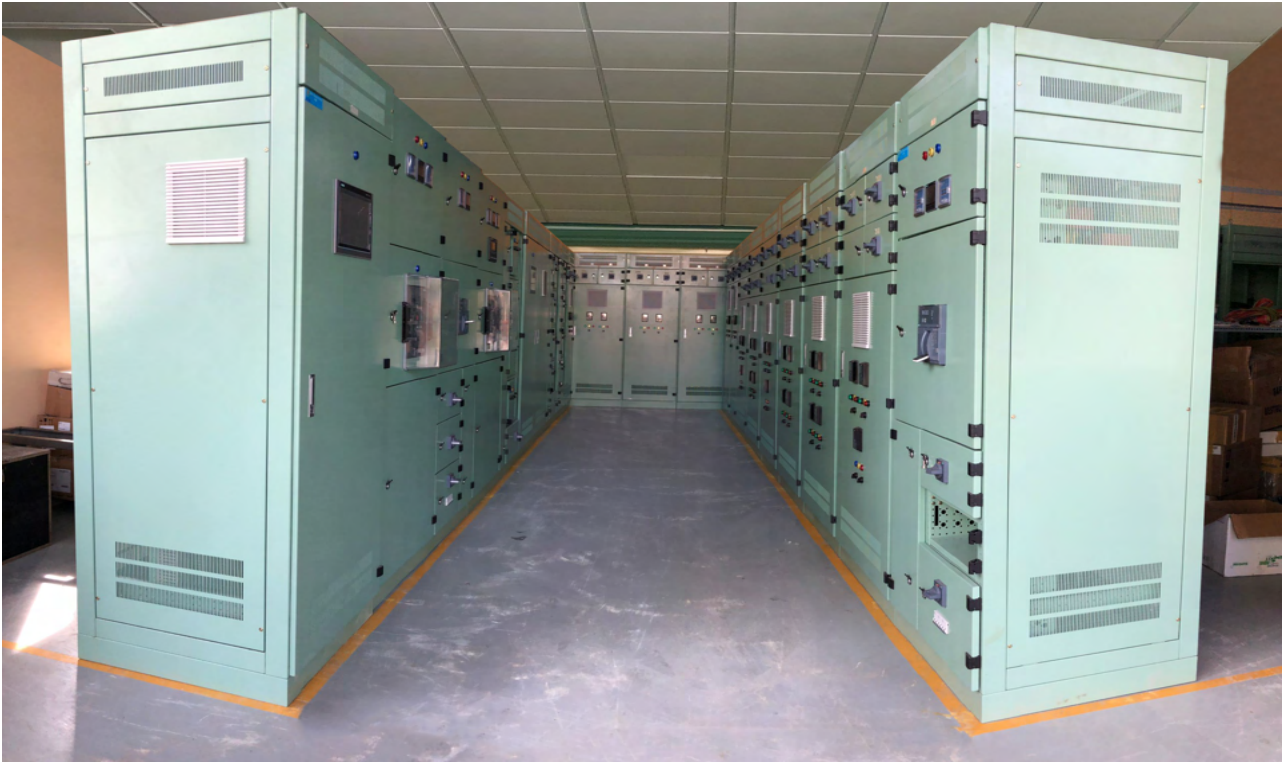
SẢN XUẤT VÀ THI CÔNG LẮP ĐẶT TỦ ĐIỆN PRODUCTION AND EXECUTION ELECTRICAL CABINET INSTALLATION
