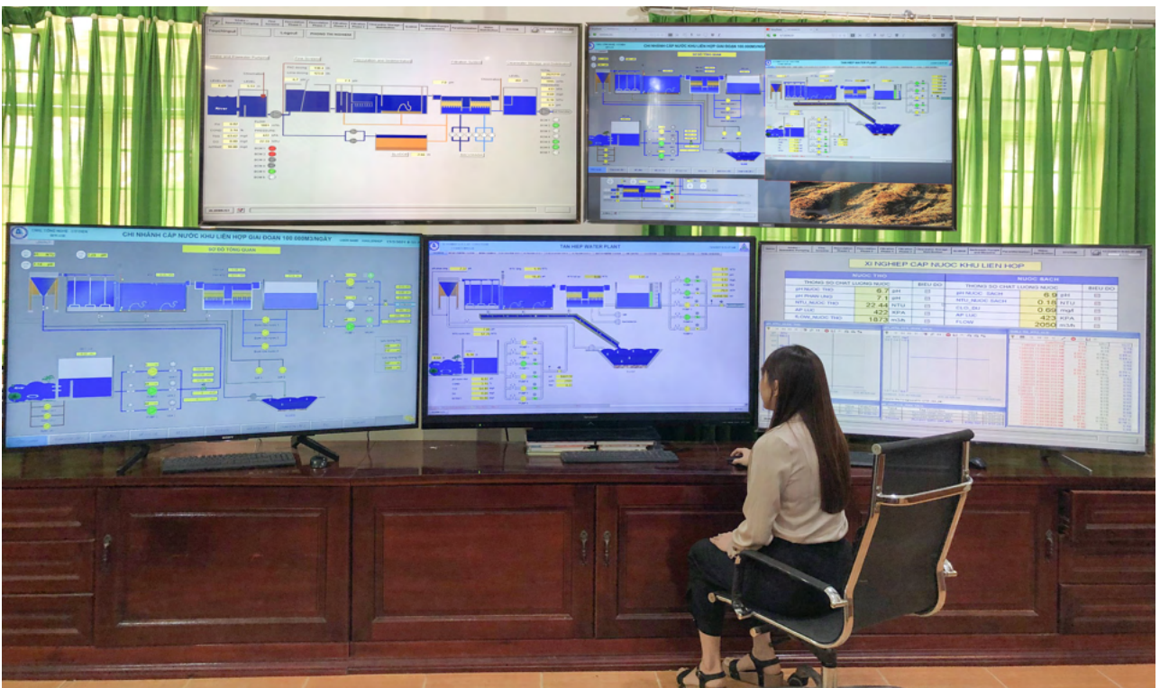
THIẾT KẾ THI CÔNG LẮP ĐẶT HỆ THỐNG SCADA DESIGNING AND EXECUTING SCADA SYSTEM INSTALLATION
