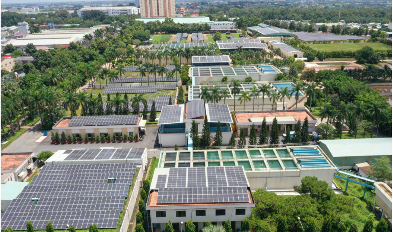
THI CÔNG LẮP ĐẶT HỆ THỐNG ĐIỆN NĂNG LƯỢNG MẶT TRỜI 4MWP - NHÀ MÁY NƯỚC DĨ AN CONSTRUCTION AND INSTALLATION OF SOLAR POWER SYSTEM WITH A CAPACITY OF 4MWP - DI AN WTP
