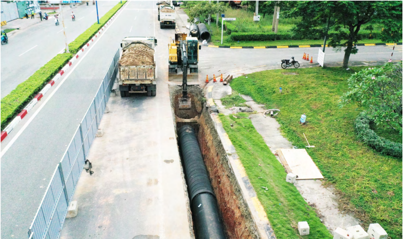
THI CÔNG LẮP ĐẶT TUYẾN ỐNG CẤP NƯỚC D1500mm DƯỚI LÒNG ĐƯỜNG NHỰA CONSTRUCTION AND INSTALLATION OF WATER SUPPLY PIPELINE D1500mm UNDER ASPHALT ROADWAY
