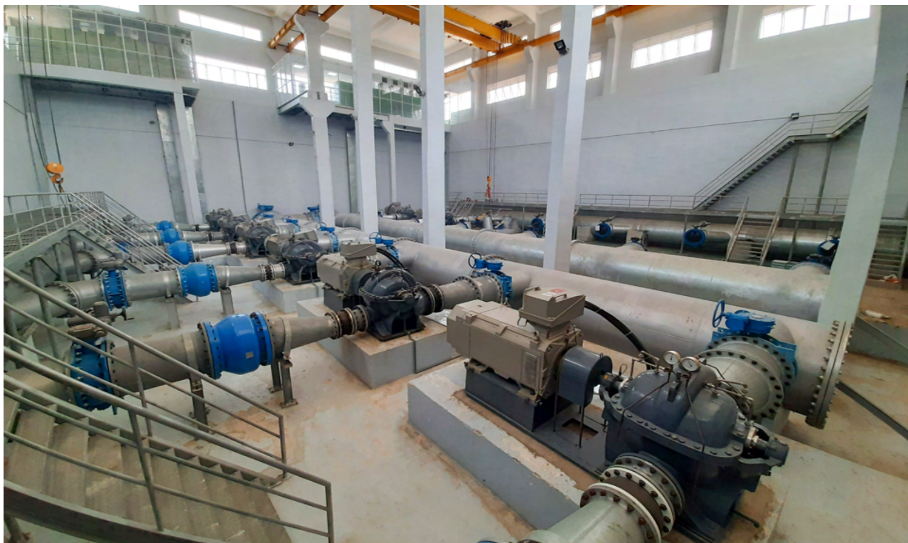
THI CÔNG LẮP ĐẶT MÁY BƠM CONSTRUCTION AND INSTALLATION OF PUMPING MACHINE
