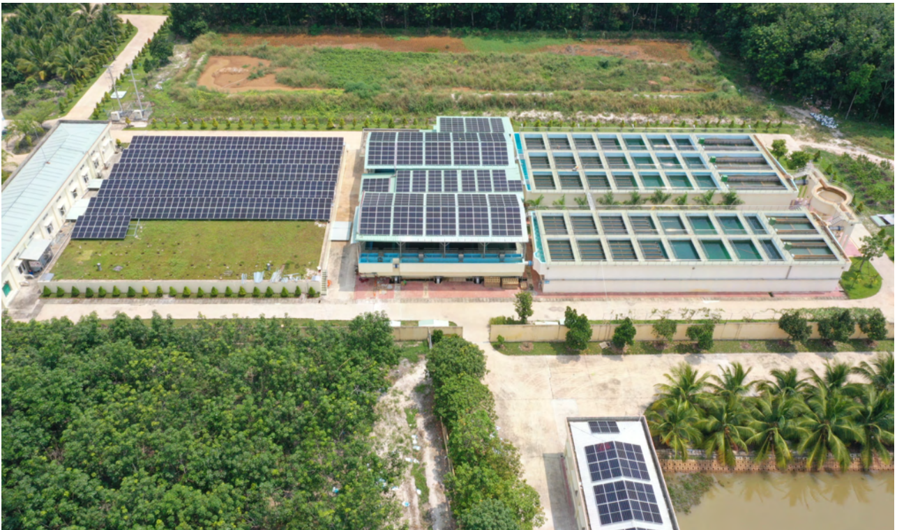
THI CÔNG LẮP ĐẶT HỆ THỐNG ĐIỆN NĂNG LƯỢNG MẶT TRỜI 400KWP - NHÀ MÁY NƯỚC BÀU BÀNG CONSTRUCTION AND INSTALLATION OF SOLAR POWER SYSTEM WITH A CAPACITY OF 400KWP - BAU BANG WTP
