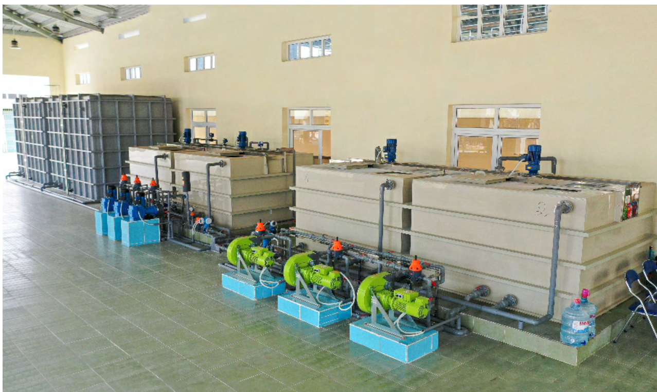
XÂY DỰNG VÀ LẮP ĐẶT THIẾT BỊ NHÀ HÓA CHẤT CONSTRUCTION AND INSTALLATION OF CHEMICAL EQUIPMENT
