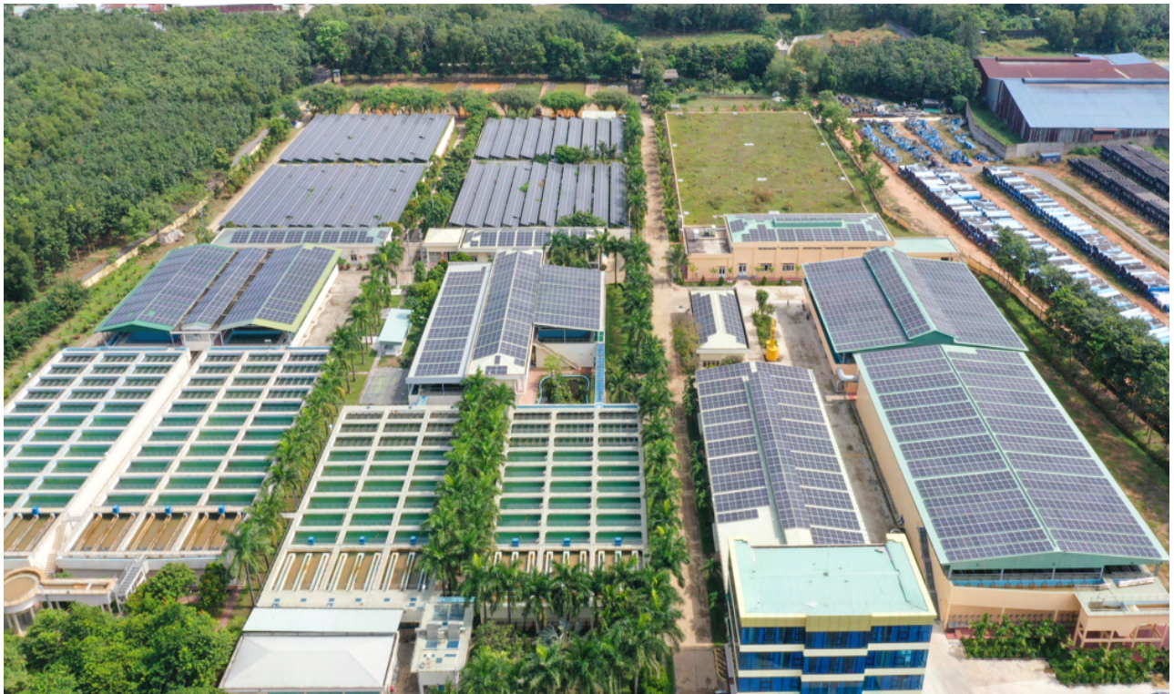
THI CÔNG LẮP ĐẶT HỆ THỐNG ĐIỆN NĂNG LƯỢNG MẶT TRỜI 4MWP - NHÀ MÁY NƯỚC KHU LIÊN HỢP CONSTRUCTION AND INSTALLATION OF SOLAR POWER SYSTEM WITH A CAPACITY OF 4MWP - KHU LIEN HOP WTP
