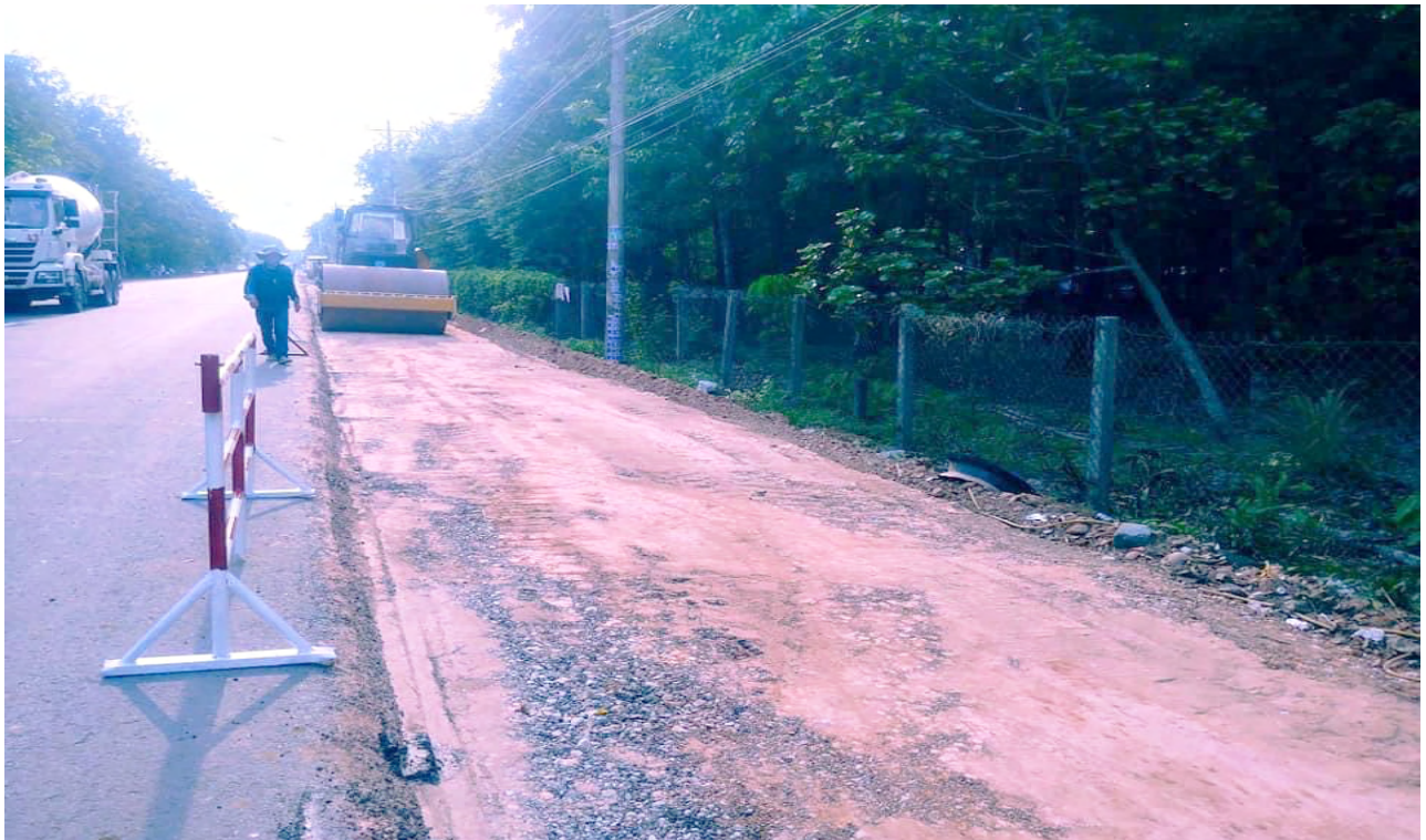
THI CÔNG MỞ RỘNG ĐƯỜNG VÀO HOA VIÊN NGHĨA TRANG CHÁNH PHÚ HÒA CONSTRUCTION OF EXPANSION THE ENTRANCE ROAD TO THE PHU HOA CHANH CEMETERY GARDEN
