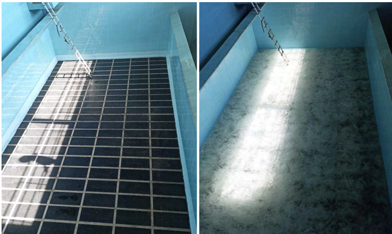
THI CÔNG LẮP ĐẶT ĐẠN LỌC CONSTRUCTION AND INSTALLATION OF UNDERDRAIN
