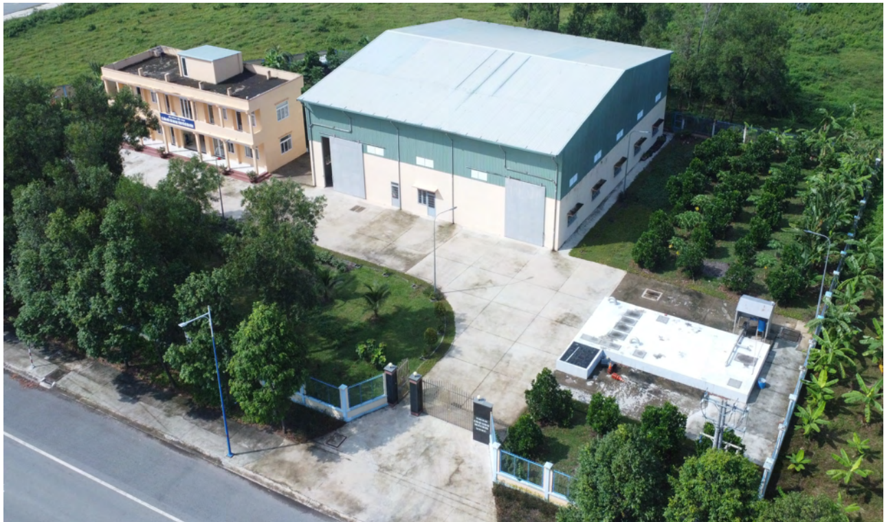
THI CÔNG XÂY DỰNG VÀ LẮP ĐẶT THIẾT BỊ TRẠM BƠM NƯỚC THẢI - TP MỚI BÌNH DƯƠNG CONSTRUCTION AND INSTALLATION OF EQUIPMENT FOR WASTEWATER PUMP STATION - BINH DUONG NEW CITY
