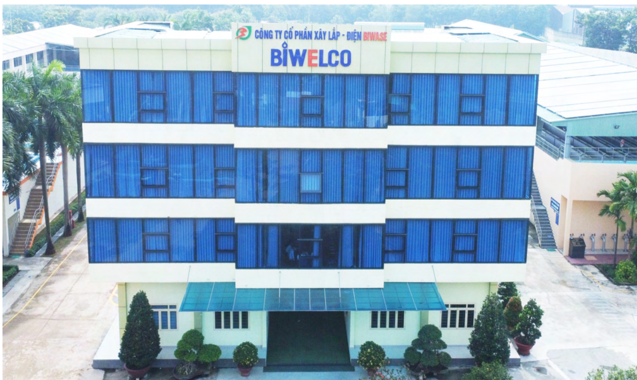
THI CÔNG TRỤ SỞ CÔNG TY CỔ PHẦN XÂY LẮP - ĐIỆN BIWASE (TÒA NHÀ BIWELCO) CONSTRUCTION OF HEADQUARTERS OF BIWASE ELECTRIC - CONSTRUCTION JOINT STOCK COMPANY (BIWELCO BUILDING)
