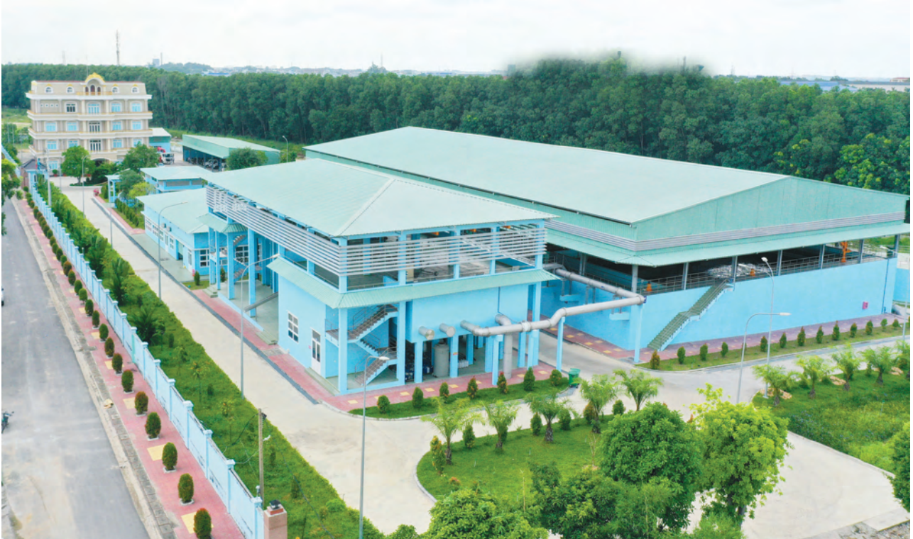
THI CÔNG HỆ THỐNG ĐIỆN, SCADA NHÀ MÁY XỬ LÝ NƯỚC THẢI ĐĨ AN CONSTRUCTION OF ELECTRICAL SYSTEM, SCADA FOR DI AN WASTEWATER TREATMENT PLANT
